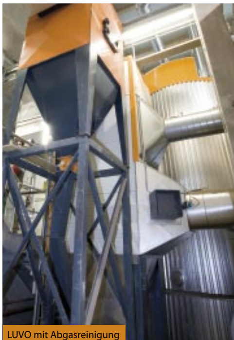
Stehender Kessel 6 MW
