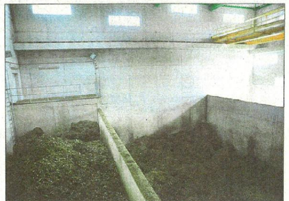
Der Vorratssilo für die Holzschnittel fasst 2000 Kubikmeter.
